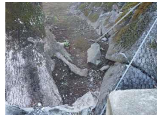
石垣基底部に生育し、石垣 を押し上げるなど変形させ る
