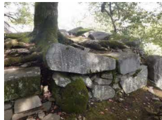
石垣天端（上部）に生育し 石垣を変形させる
