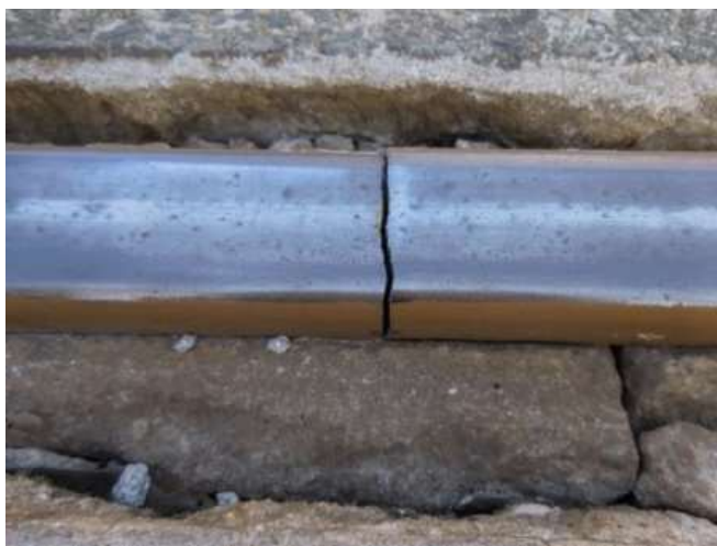
市電レールの破断
