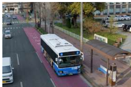
▲路面標示等明確化
