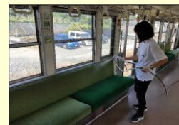
▲ コーティング剤施工
