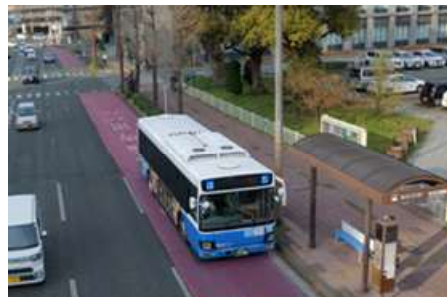
▲ 路面標示等明確化
