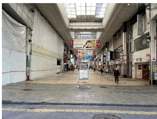
下通アーケードの状況
