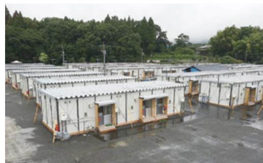
応急仮設住宅の整備
