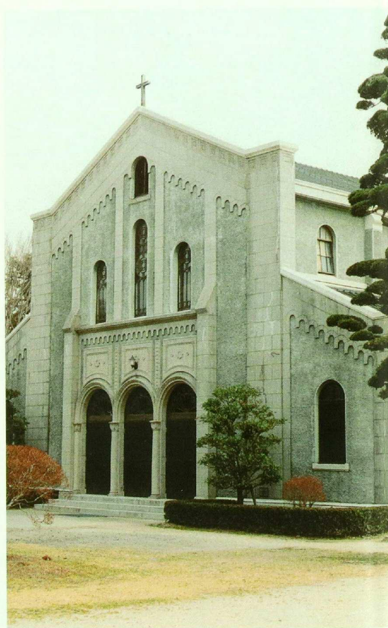
九州学院高等学校講堂兼礼拝堂 Chapel at Kyushu Gakuin High School
