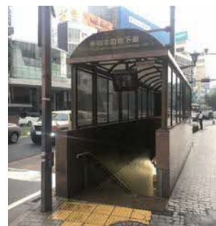
手取本町地下道出入口(整備前)
