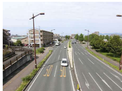
(一)熊本空港線（国体道路） （長嶺小学校付近）
