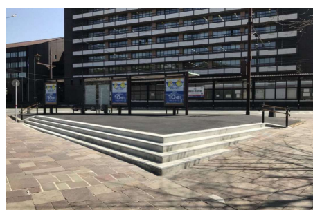
花畑ポンプ場跡地整備
