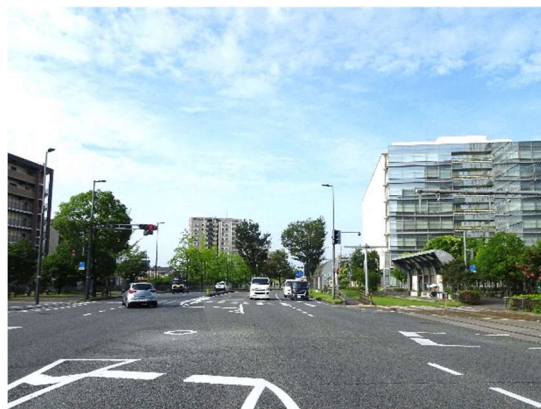
合同庁舎前交差点（無電柱化、街路樹整備、軌道緑化による景観整備の例）
