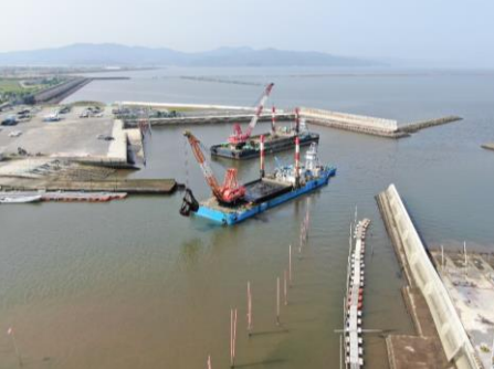
漁港機能維持のための浚渫工事
