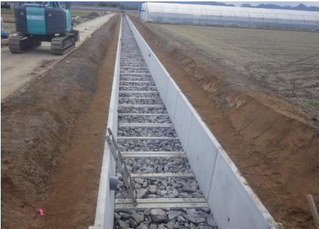
農業用排水路の整備
