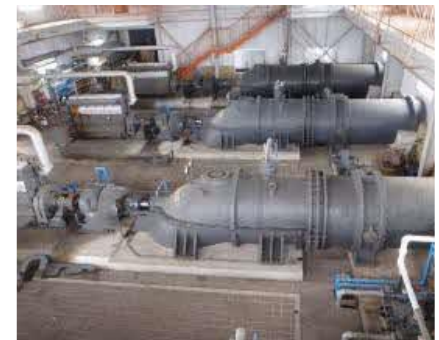
排水機場の整備
