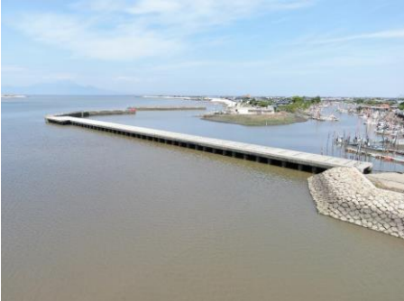
天明漁港の整備(防波堤、物揚場)
