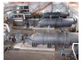
排水機場の整備
