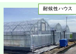
台風等の災害に強い施設等の導入
