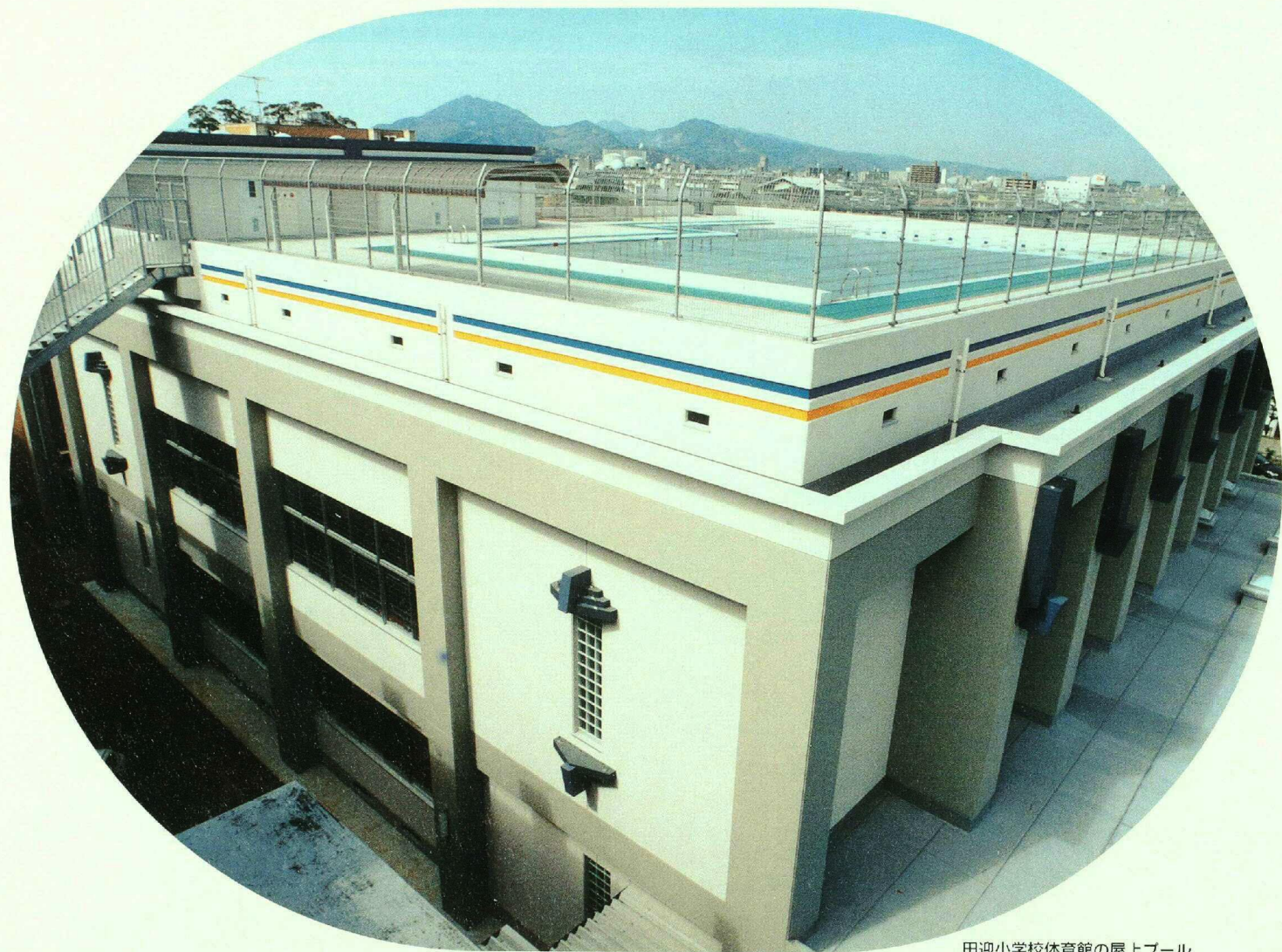
田迎小学校体育館の屋上プール
