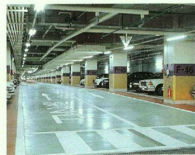
辛島公園地下駐車場
