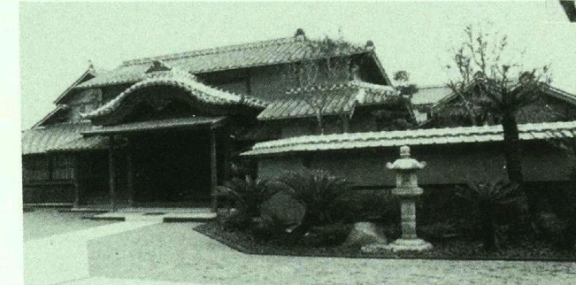
平成5年9月、 大名屋敷・旧細川刑部邸完成
