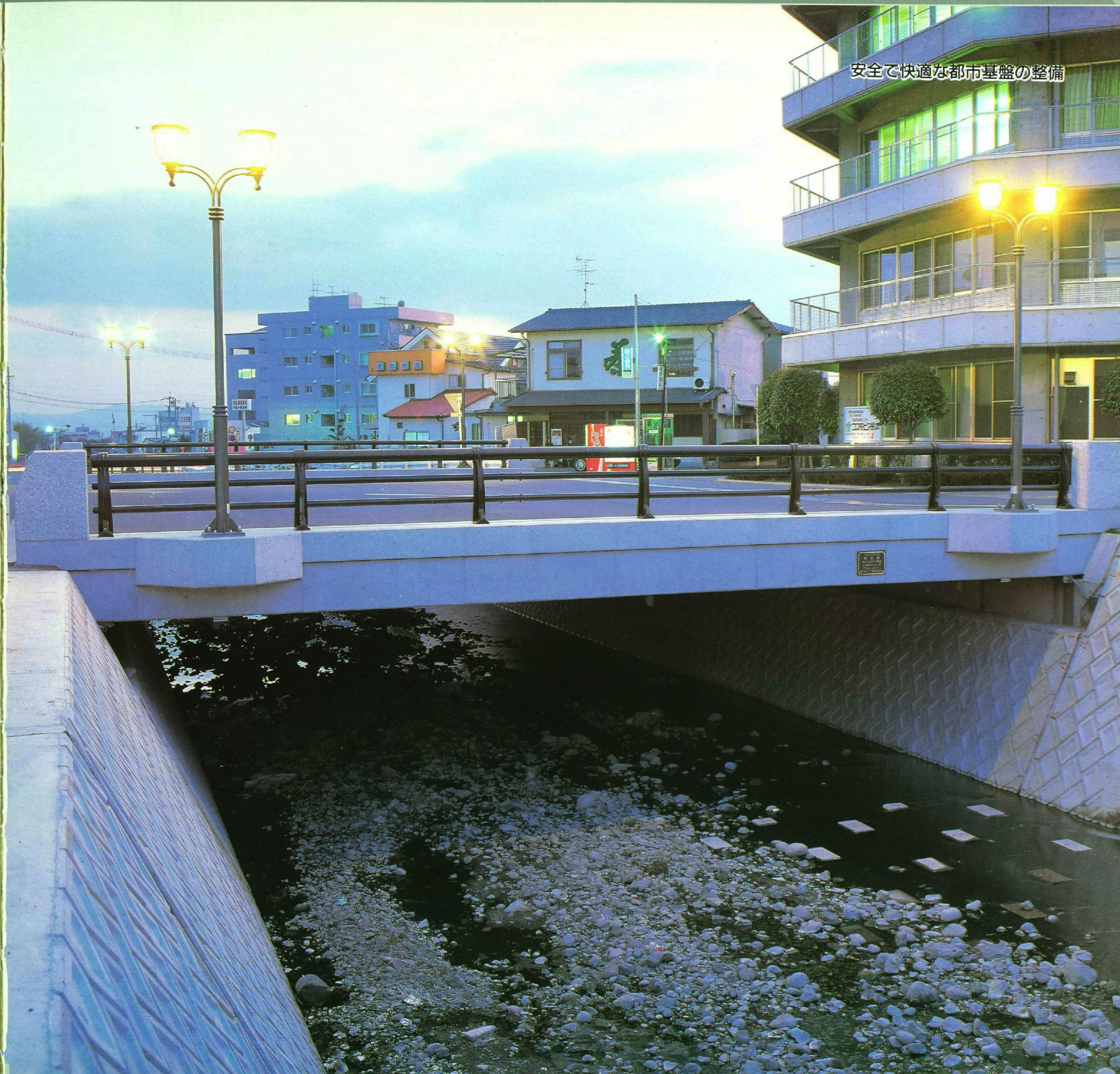
改修された健軍川（京塚上橋付近）
