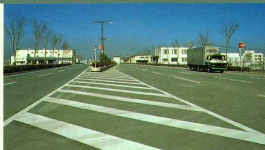
建設が進む都市計画道路本荘大洲線（流通団地内）
