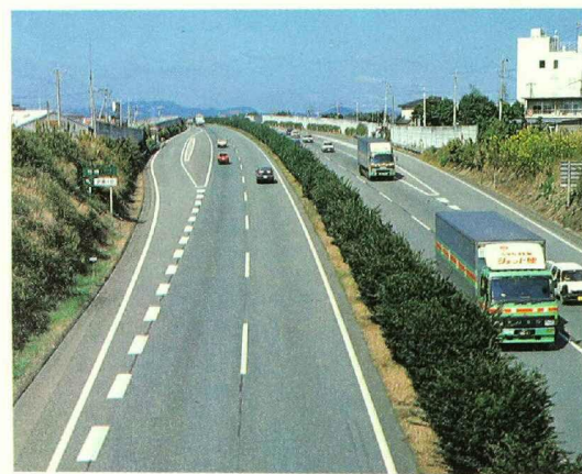
九州縦貫自動車道
