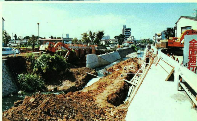
健軍川改修工事
