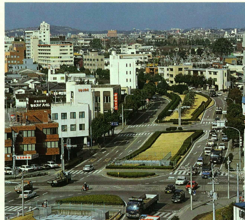
一般国道57号熊本東バイパス
