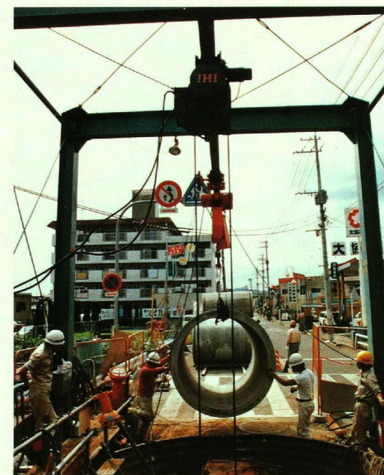
下水道幹線工事
