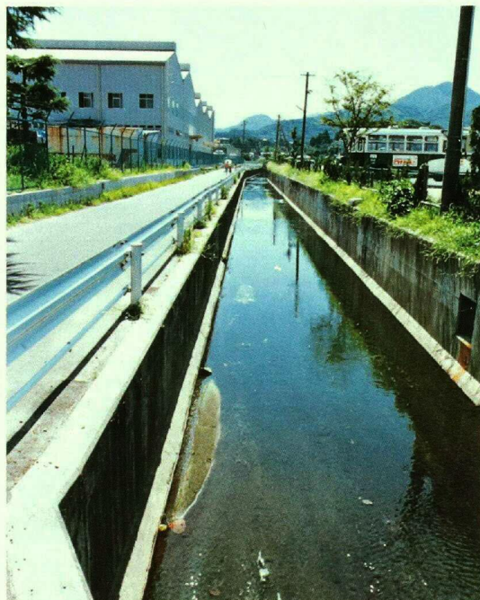
上熊本都市下水路
