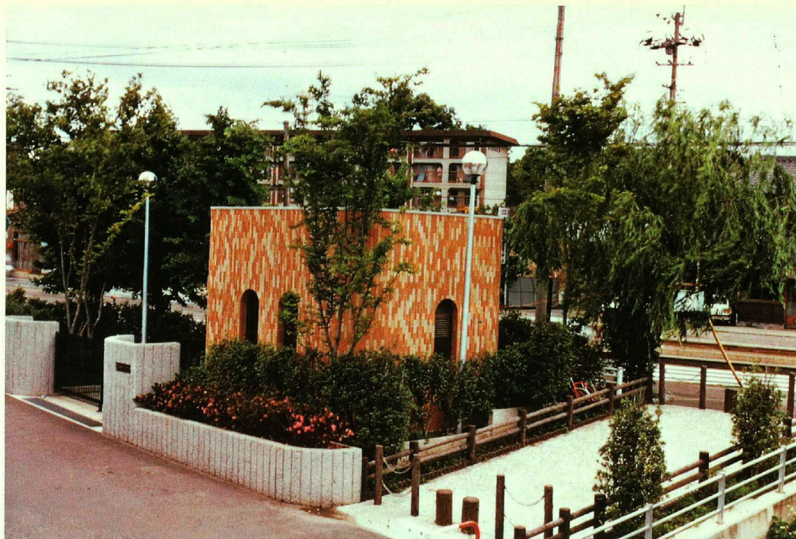
健軍中継ポンプ場
