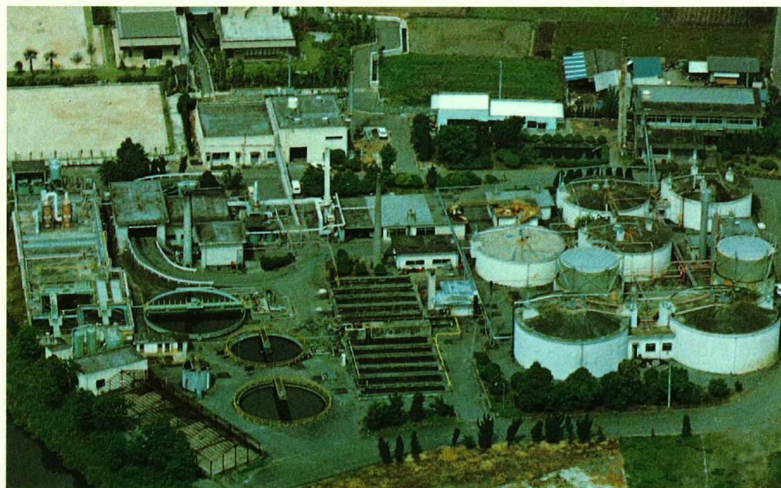
東部汚水処理場全景
