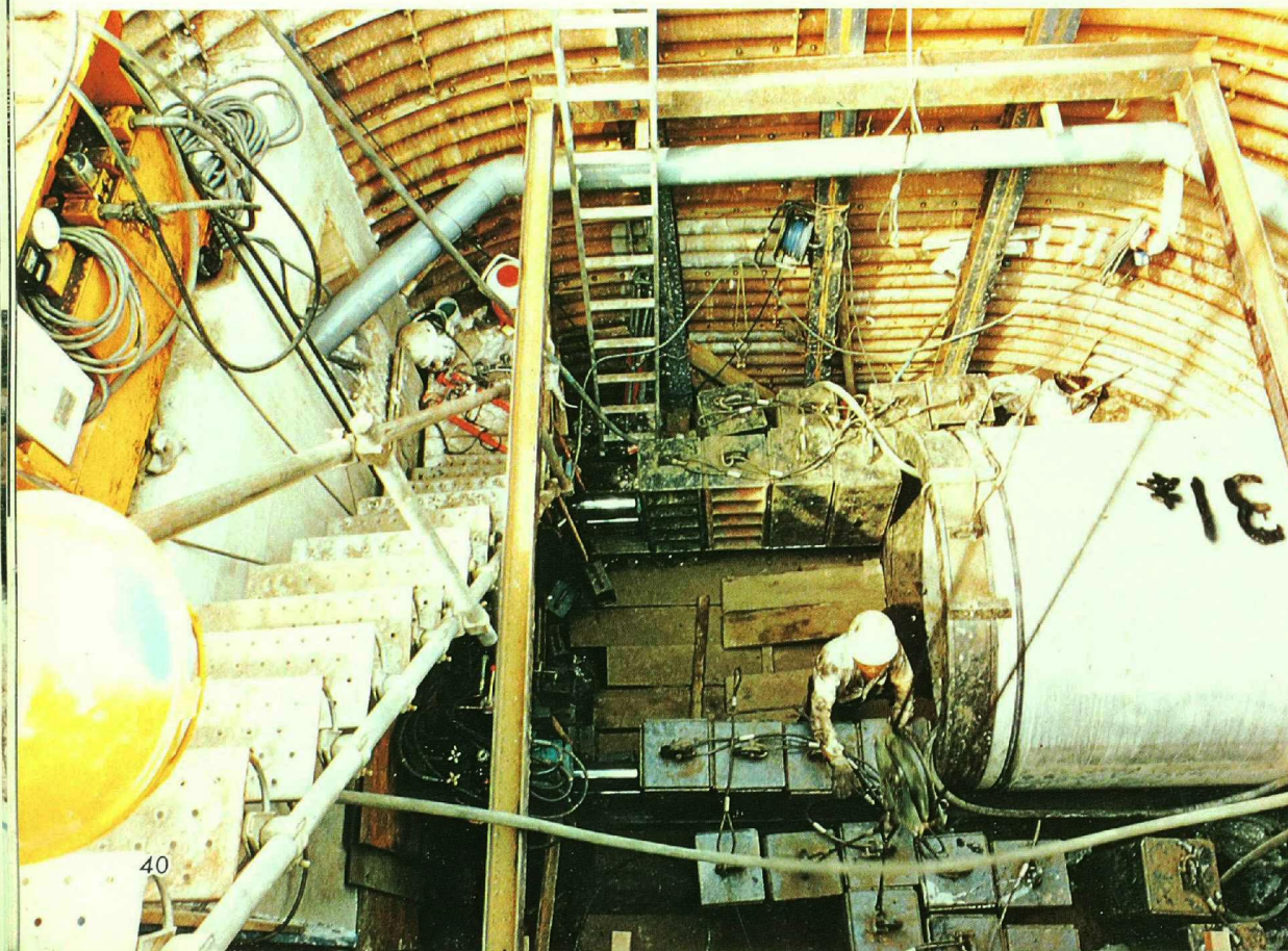
下水道幹線工事
