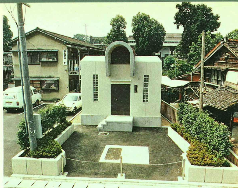
渡鹿第二ポンプ場
