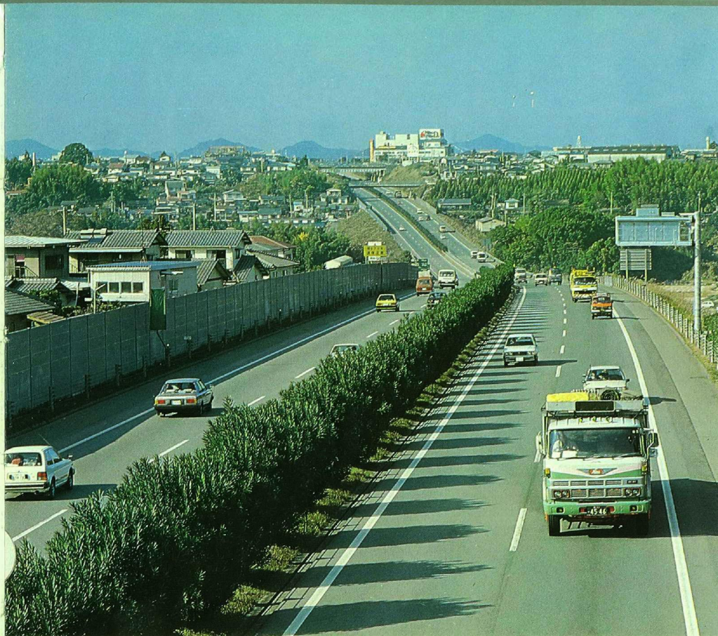
九州縦貫自動車道
