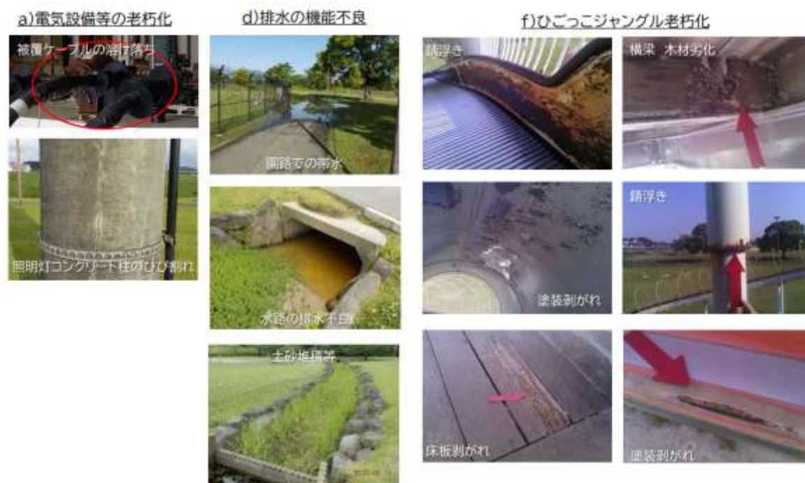
図 6 主要な老朽化の状況
