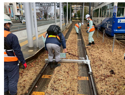
【R7.2より導入した軌道検測機による検測の様子】
