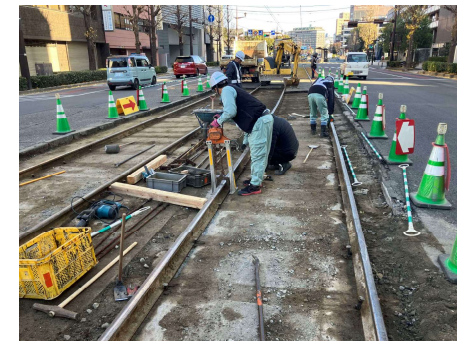
【軌道整正の様子】
