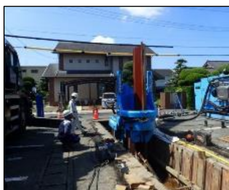
【液状化対策工事】
