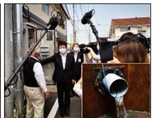
【排水ポンプ起動・集水状況】
