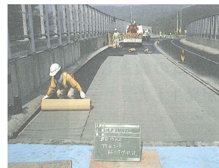
橋面防水シート布設により雨水浸透防止
