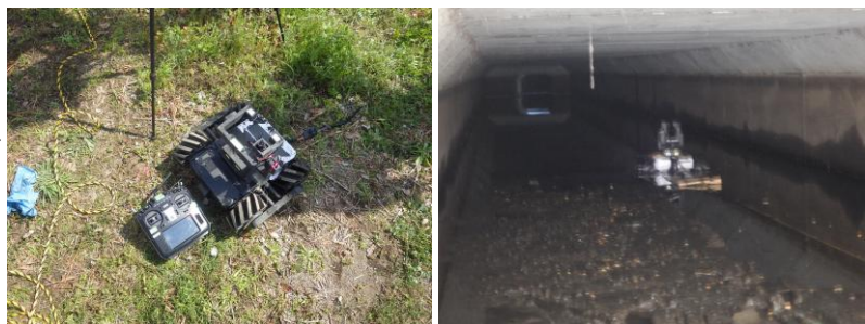
点検ロボットによる点検（作業効率化と精度向上）
