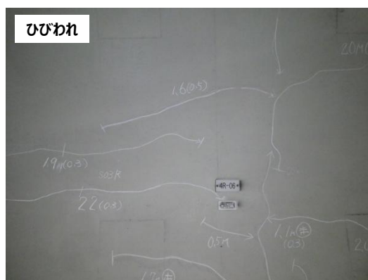
出典：熊本市 トンネル定期点検結果
