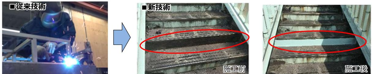
腐食部を鉄板溶接で補修
