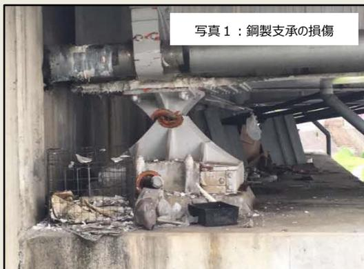
写真 1：鋼製支承の損傷
