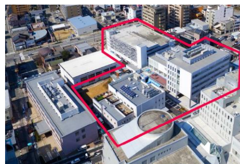
富山県某所 小学校跡地活用での県境拠点施設
