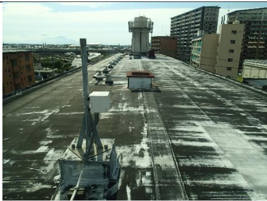
屋上防水 (改修前)
