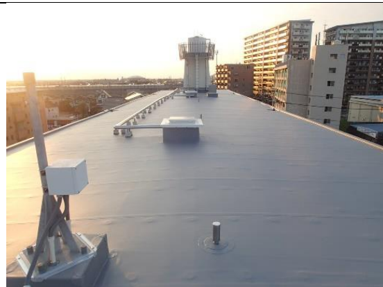
屋上防水 (改修後)
