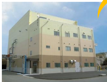
南部浄化センター固形燃料化施設 で製造した乾燥汚泥を利用。
