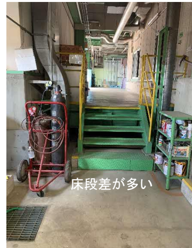
図 4-5 工場棟写真③
