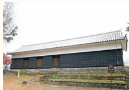
復旧後の監物櫓
