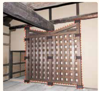
補強のためにつけた壁（赤点線内）
