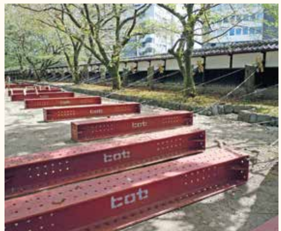
2015年台風被害の応急措置
