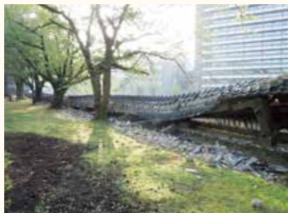
熊本城側からみた長塀
