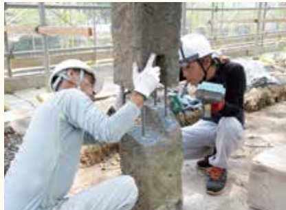
地震で折れた石柱をつなぎ合わせるようす
