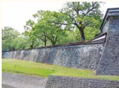
坪井川側からみた長塀
