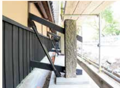
金物とコンクリートで補強した長塀
