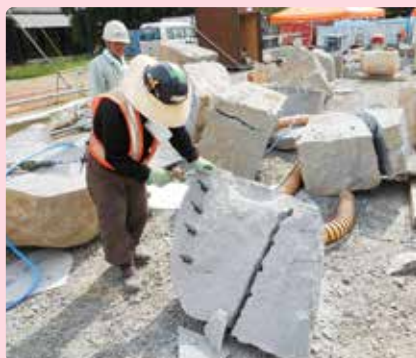
新しく積む石の加工
