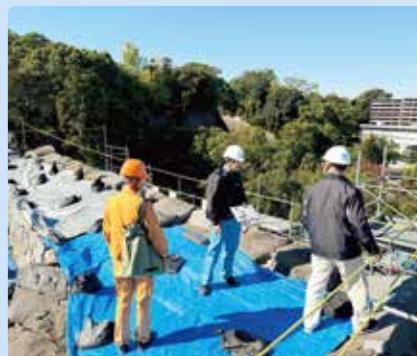
積みなおした石垣の完成検査
