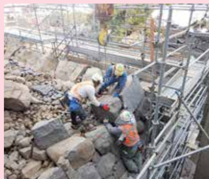
石垣の積みなおし
