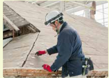
釘穴の痕跡調査
