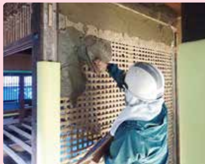
土壁を塗る作業
