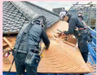
屋根の仕上げ作業
