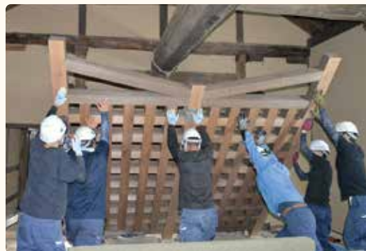
木を組んでつくった補強の壁を取り付けるようす (監物櫓)
