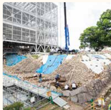
続櫓下の石垣を 解体しているようす
