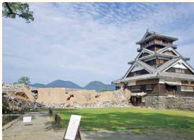
熊本地震後の宇土櫓 五階櫓の左側にあった続櫓はすべてたおれました
