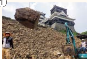
くずれた石垣の石材回収
