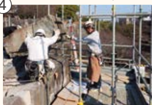
石垣の積みなおし
