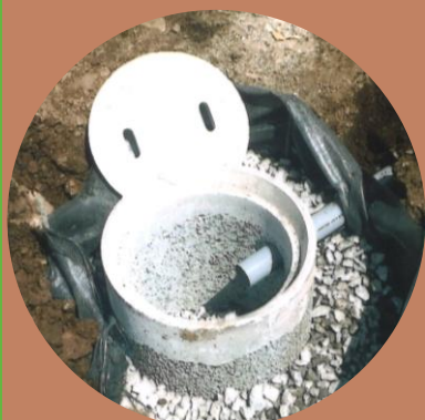
浸透ます（施工中）
