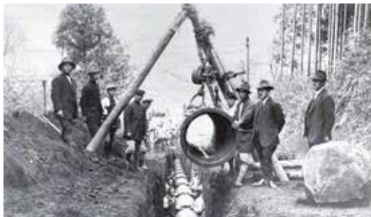
送水管布設工事
