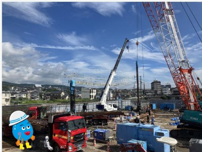
地面を掘るために鋼矢板を打ち込んでいるよ
