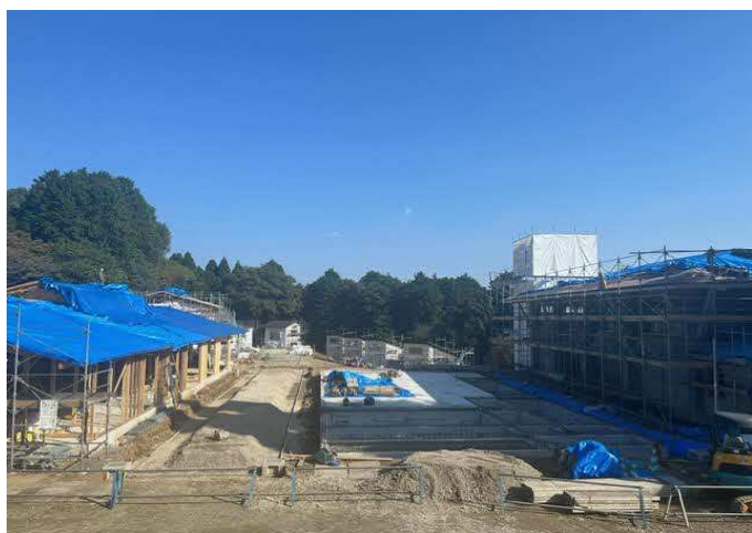
(新施設施工中)
