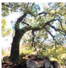
〈石垣上部に生育し、 石垣を押し出すなど 石垣を変形させる樹木〉
