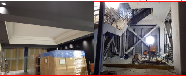
内部工事状況
