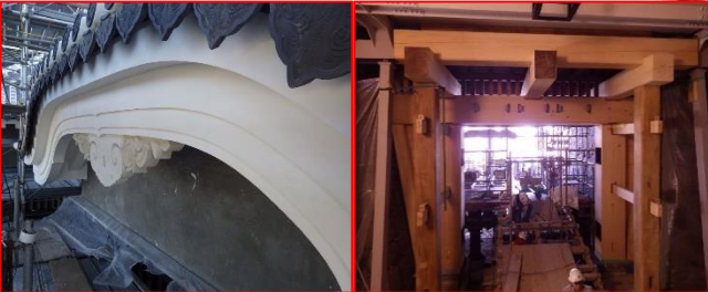
外部工事状況
