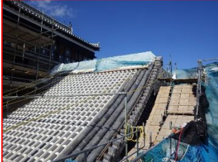
続櫓外部工事状況
