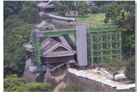
＜飯田丸五階櫓の倒壊防止措置＞
