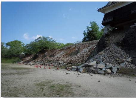
西出丸北側の石垣
