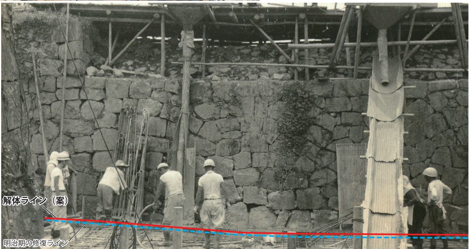
小天守穴蔵西面石垣 (H505) 南側
