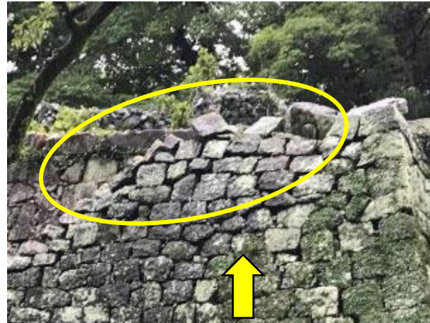
倒木により須戸口虎口石垣 天端石が変状
