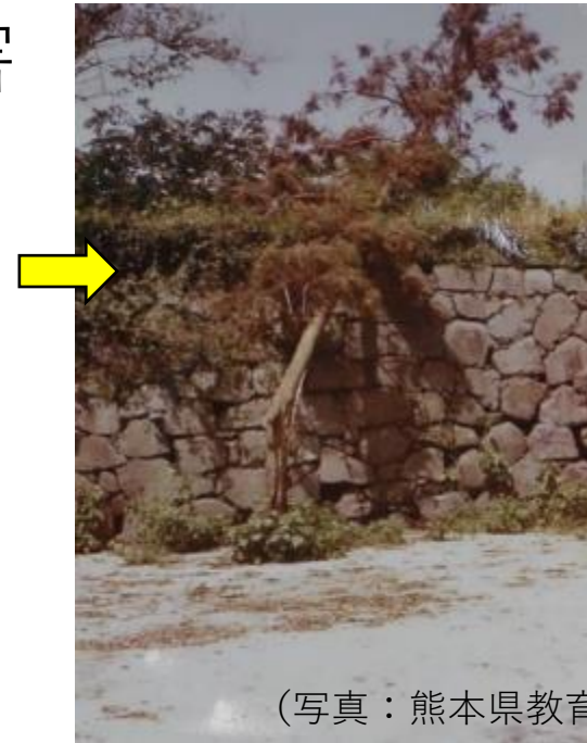
倒木により加藤神社石垣天端石が崩落
